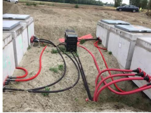
الشكل يشمل على الغرف الخرسانة الرئيسية لنظام مراقبة التفريغ الجزئي PD (أعلى). وصندوقين من المعدن للروابط المتبادلة cross bonding وللروابط المتوازية (أعلى يسار) ومكونات الحماية والتغذية للجهد المنخفض (أسفل)
